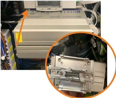
Das LAN-Modul wird von der Befestigungsschiene (Hinterseite) gelöst. Dies geschieht über einen Entriegelungsschieber, welcher geräteseitig hinten gedrückt wird. Eine Entnahme nach vorne wird so ermöglicht.
